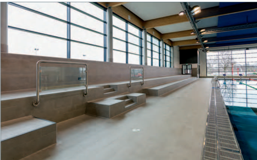
■ ... Tragkonstruktion und Beckenumgang ...
